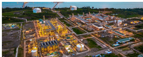
タンクーLNG基地 (インドネシア)
