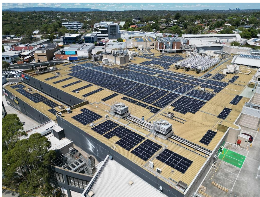
【NGG が設計・施工・メンテナンスを担当する太陽光パネルが設置されるショッピングセンター(ビクトリア州)】
