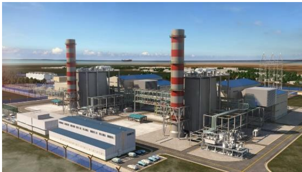
【液化天然ガス(LNG)火力発電所】
