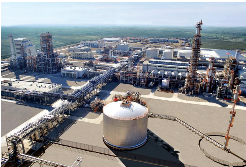
【肥料製造プラントの全景】
