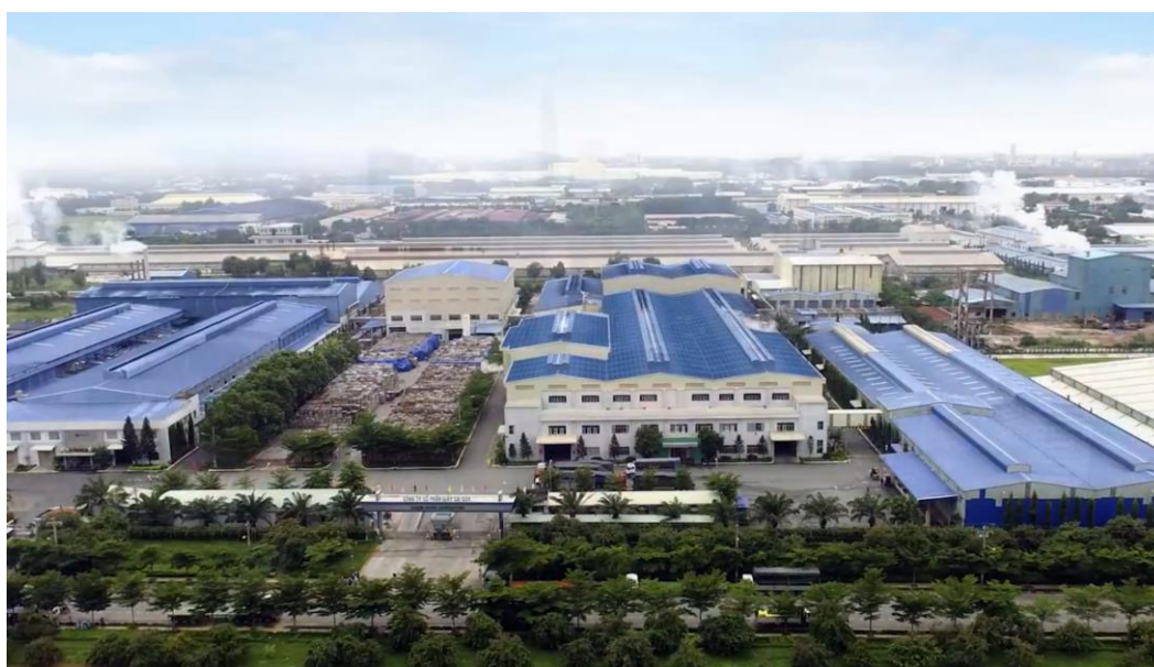
【サイゴン・ペーパー社 工場全景】
