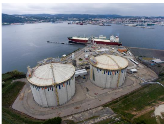
【ムガルドス LNG 受入基地全景】
