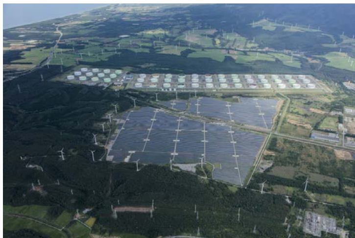
[Kamikita Rokkasho Solar Power Plant]
