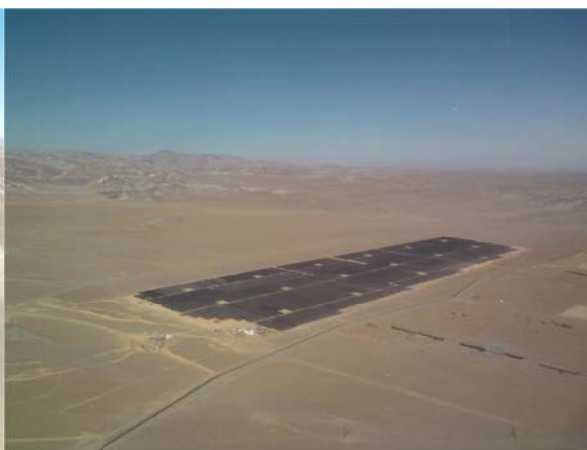
【レパルティシオン太陽光発電所】
