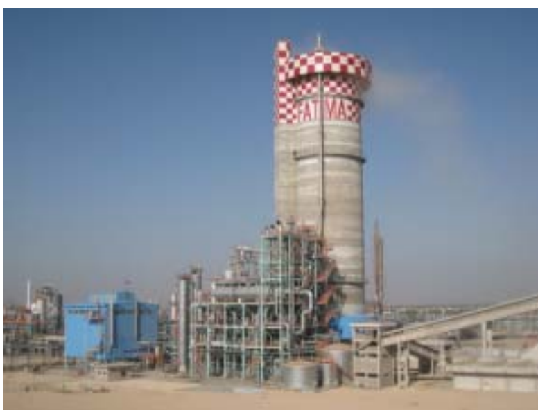
【 完成した尿素製造設備 】
