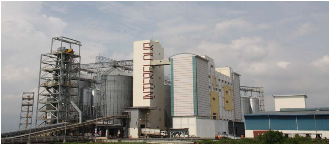
IFV 社の製粉工場、サイロ、穀物エレベーターと荷役コンベヤー
