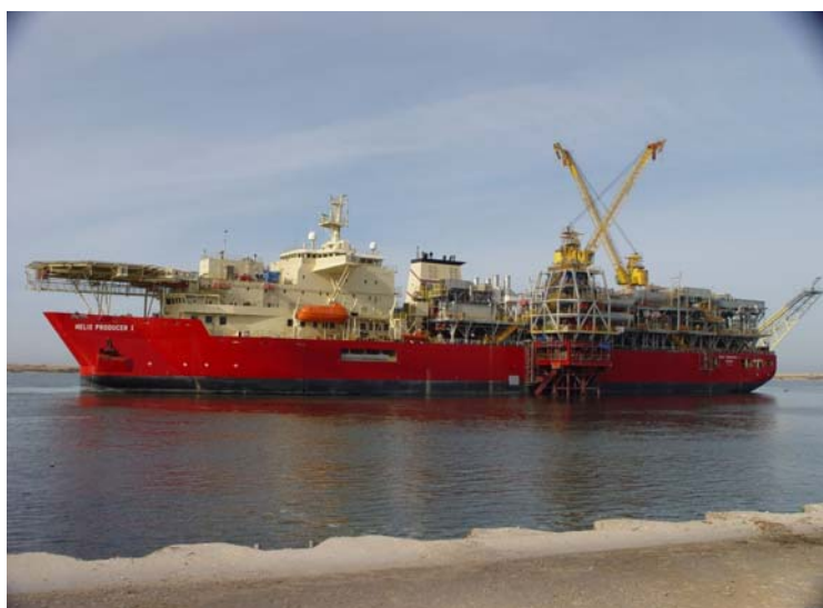
【浮遊式石油生産設備】
