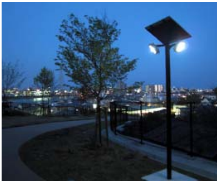
【 太陽電池パネルと組み合わせた LED 照明 】
