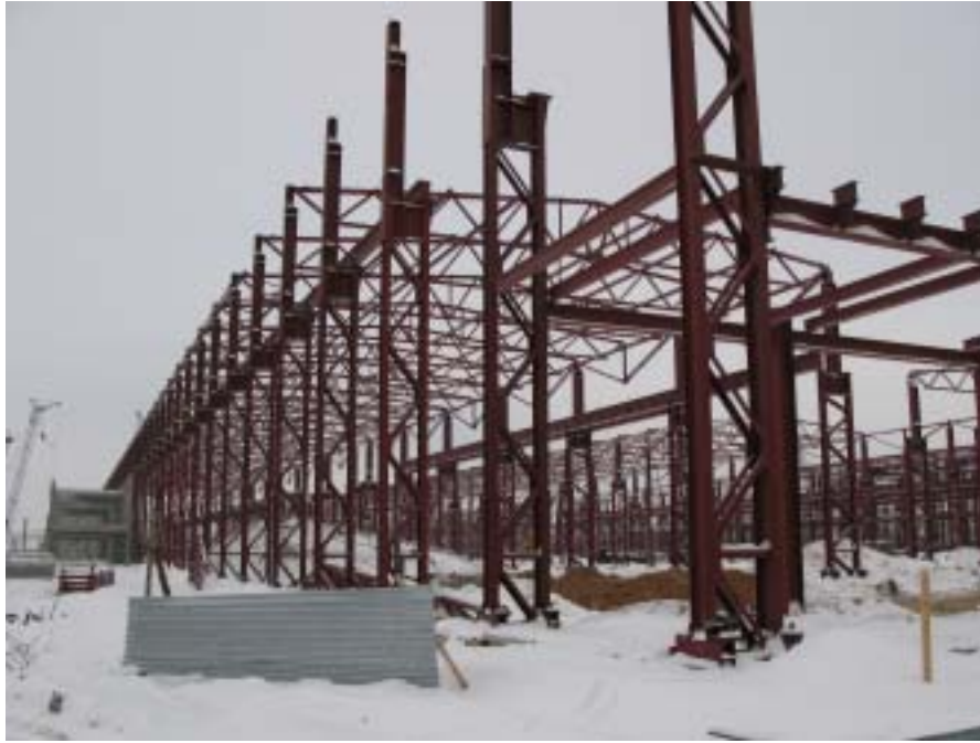
【カナッシュ市に建設中の貨車工場】
