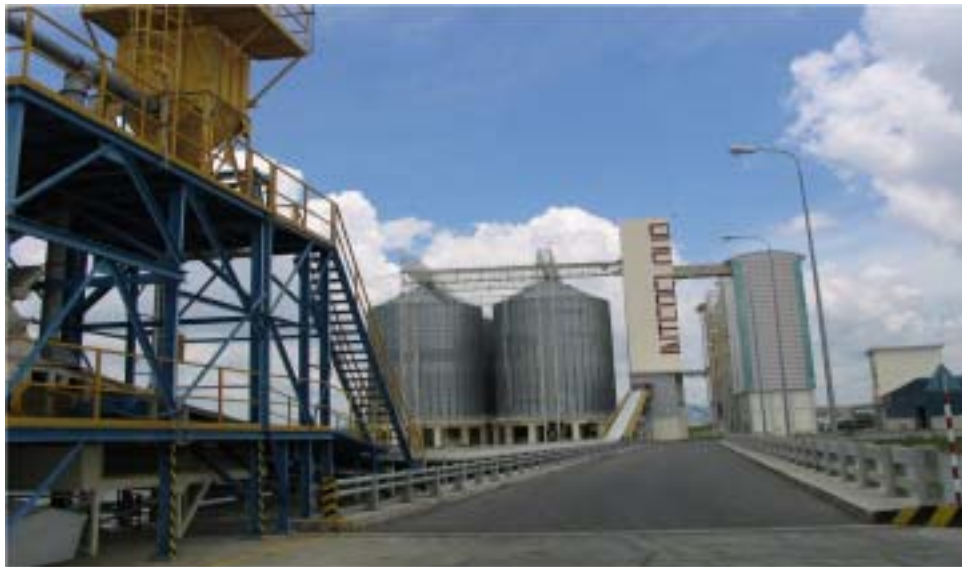
IFV 社の製粉工場、サイロ、穀物エレベーターと荷役コンベヤー
