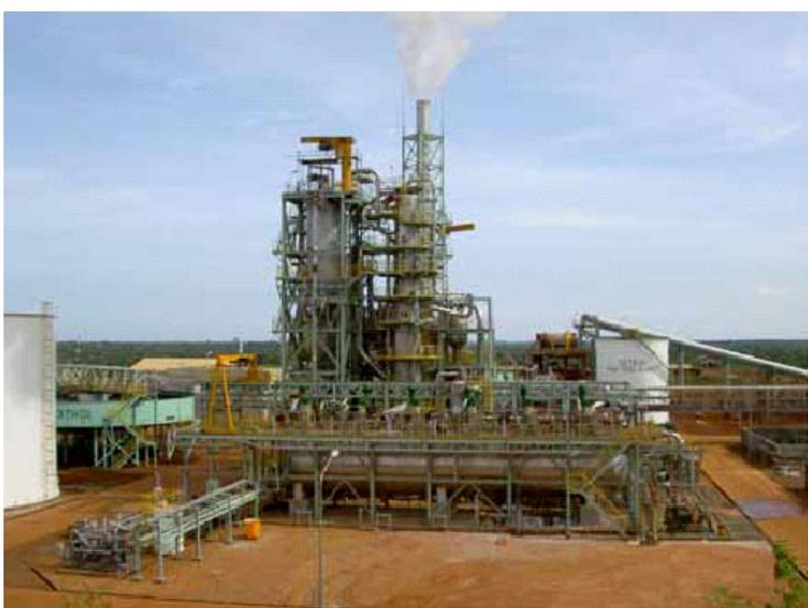
フィリピン ニッケル精錬：HPAL工程（オートクレーブ設備）
