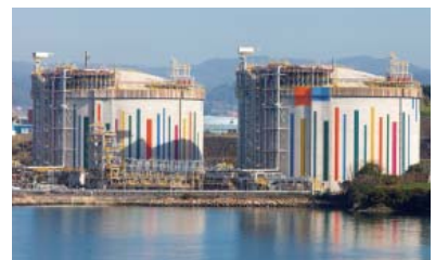
ムガルドスLNG受入基地(スペイン)
