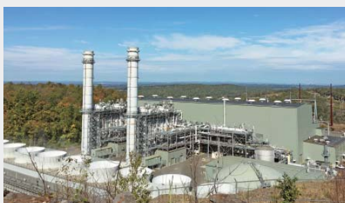
クリーン・エナジー・ガス火力発電所(米国)
