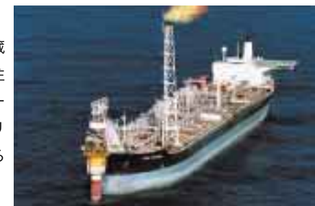
東ティモール沖合いにて操業中の海上石油生産設備
