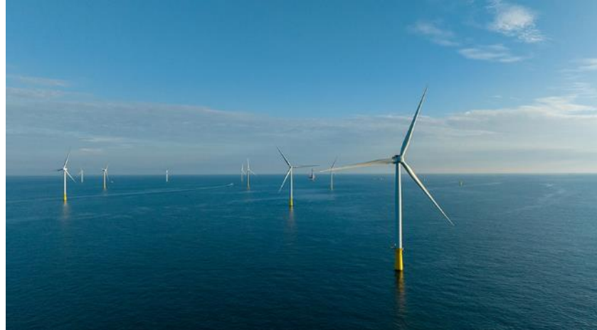
洋上風力事業(台湾) (提供元: Offshore Wind Farm Yunlin)
